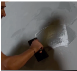
Applicazione Applicare il prodotto in due mani con una spatola
